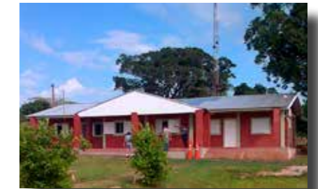
Puesto de Control San Borgita
